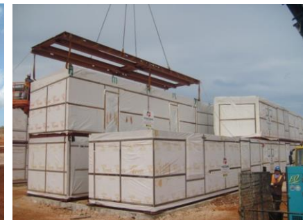
모듈 설치 및 외부 마감
