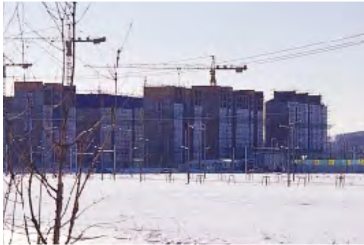
공항신도시에 건설 중인 아파트 단지
