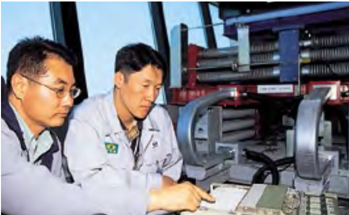
진도 7의 강진에도 견딜 수 있도록 설계된 관제탑의 복합형 제진 장치
