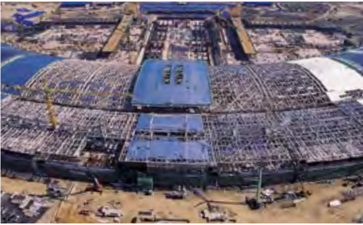
지붕 구조물 공사
