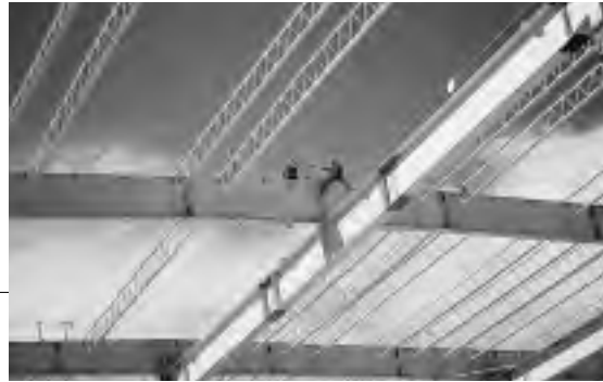
화물터미널의 지상부분은 철골조로 시공하였다
