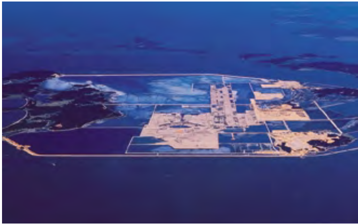
1996년, 1단계 건설공사 부지 완공 직전
