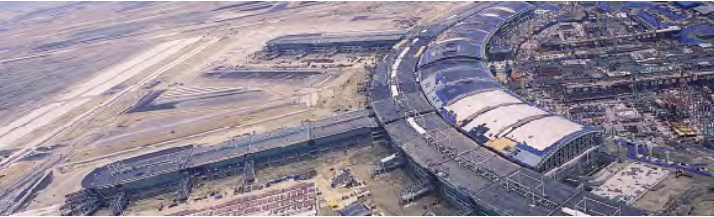
외벽 및 마감공사
