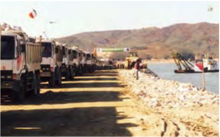
방조제 끝막이 공사(1994. 10. 29)
