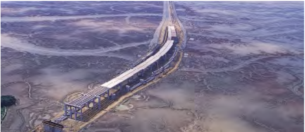
고속도로 건설 현장
