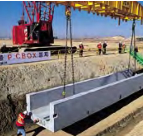
지하 구조물 공사
