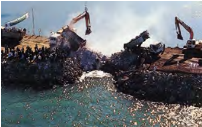
방조제 끝막이 공사
