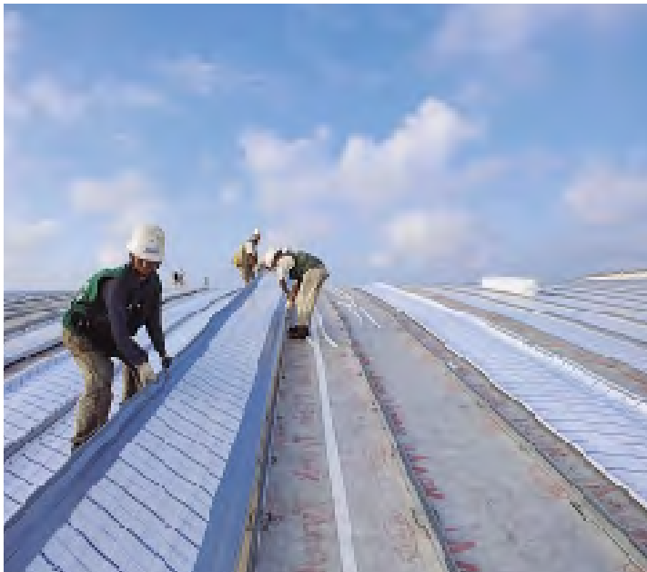
지붕 마감 작업
