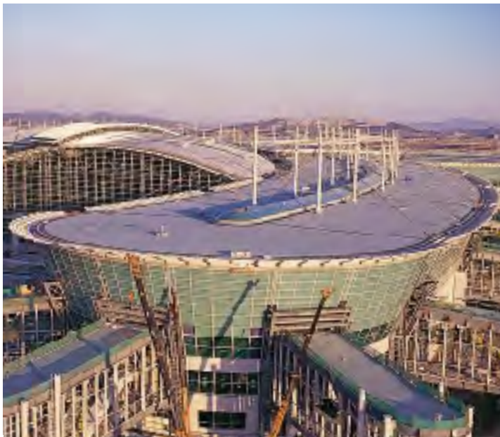
건물 외벽 마감
