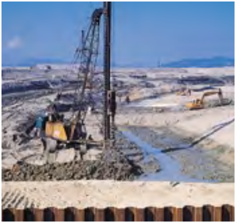
Sand Drain 공법, 모래 기둥을 지하 13m까지 심고 있다
