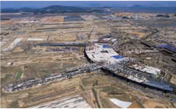
앤티러 및 전면 고가교량 공사
