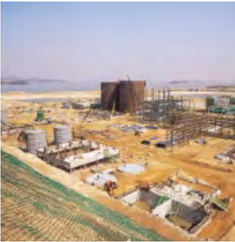
열병합발전소 시공 모습
