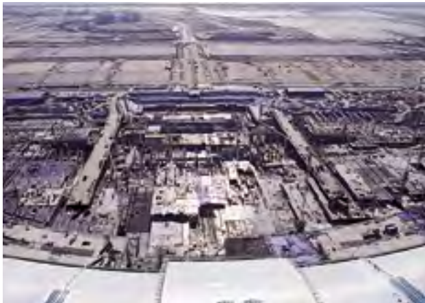
IAT 등 지하 구조물 공사
