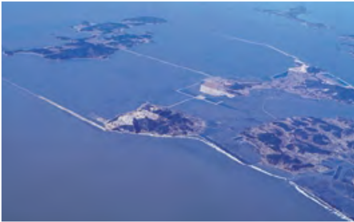
1993년, 영종도와 용유도를 잇는 방조제 공사 초기
