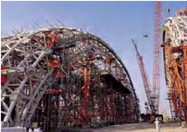
슬라이딩 공법으로 블록을 조립하는 모습
