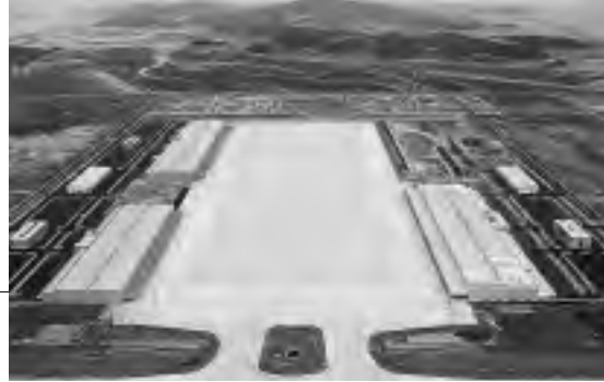
연간 170만 톤의 화물처리가 가능한 화물터미널 전경
