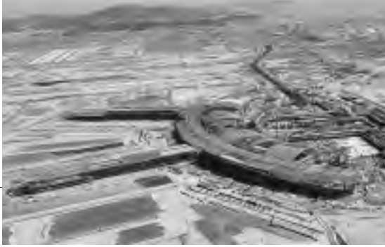
여객터미널 트러스 공사에는 20톤 규모의 타워크레인 9대와 550톤 규모의 크롤러 크레인 10대가 동원되었다
