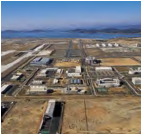
동측 지원시설 단지에 위치한 부대 건물들
