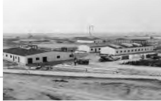
신축중인 현장사무소 전경
