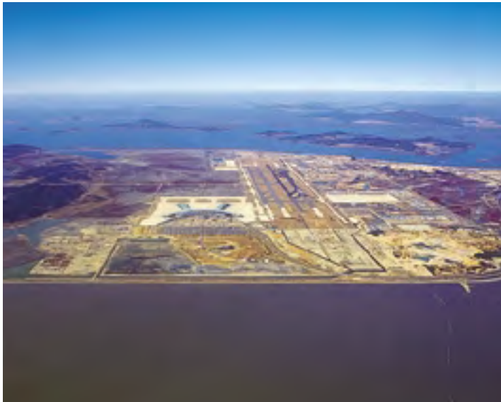
2000년, 1단계 공사 완료 후 개항을 기다리고 있는 모습
