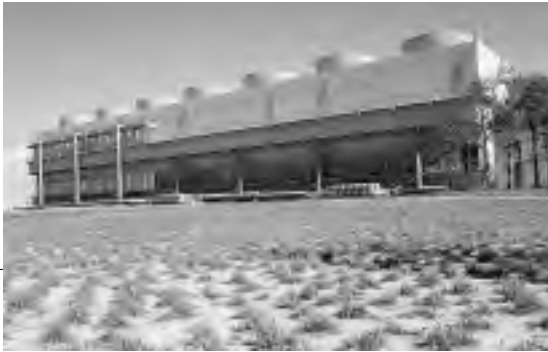
동력동 A 전경. 주변전소 B로부터 수전하여 여객터미널 · 교통센터 · 탑승동에 냉 · 열원을 공급한다
