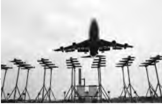
전파로 항공기의 안전착륙을 유도하는 계기착륙시설 전경
